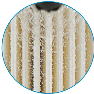
➤ **Indirekte adiabate Verdunstungskühlung** im Wärmeübertrager. Hohlkegeldüsen gewährleisten eine hauchfeine, homogene Verteilung des Wassers in der Abluft.
